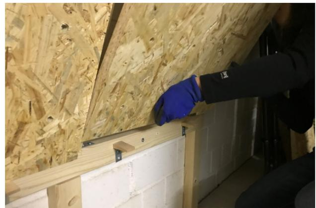
Bild 22: Einpassen der Paneele (geneigte Wand)
