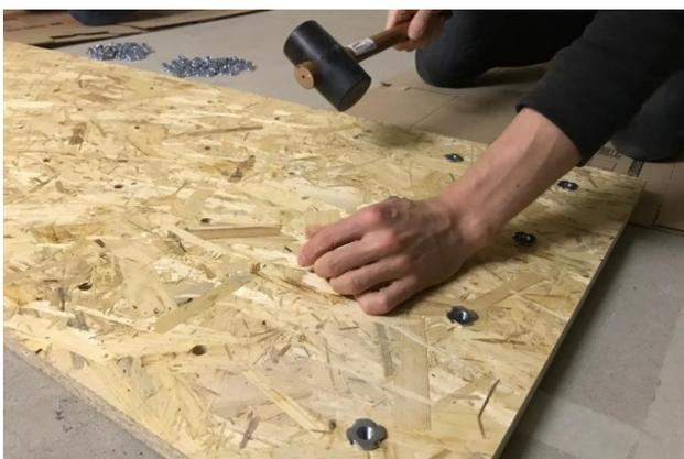
Bild 19: Einschlagen der Einschlagmutter mit dem Gummihammer
