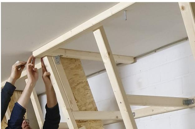
Bild 15: Problemlösung durch ergänzende Deckenbalken
