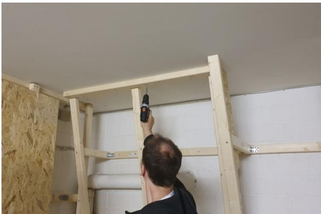
Bild 13: Verankern der Deckenbalken mit Langschaftdübeln
