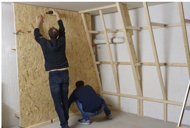
Bild 21: Befestigen der Paneele (senkrechte Wand)
