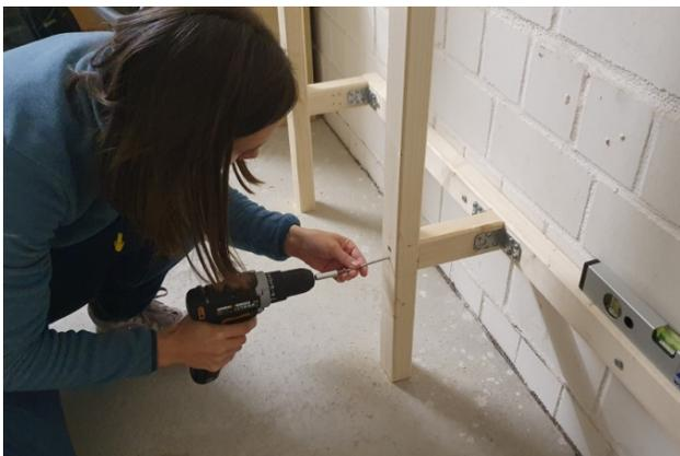
Bild 9: Befestigung der Paneel-Trägerbalken (senkrechte Wand)
