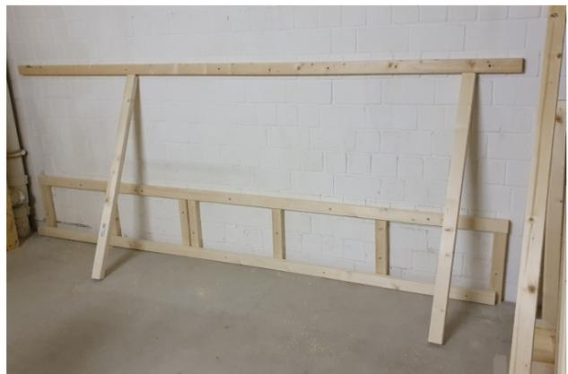
Bild 6: Ausrichten der Wandbalken mit provisorischen Stützen
