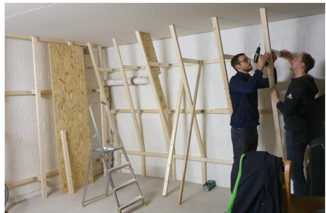
Bild 12: Der letzte Trägerbalken wird verschraubt
