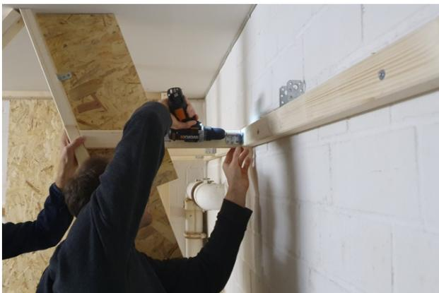
Bild 11: Einpassen waagrechter Trägerbalken (geneigte Wand)
