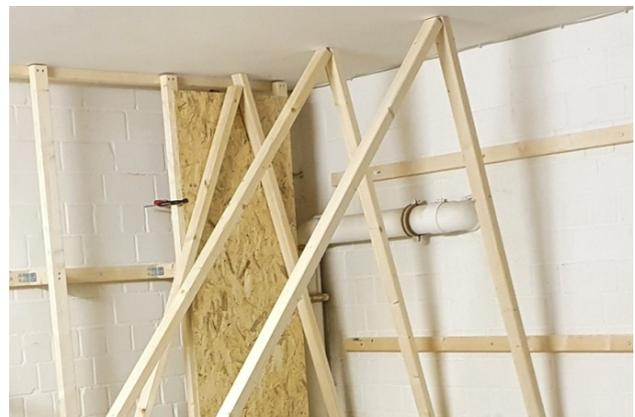
Bild 10: Provisorisch fixierte Paneel-Trägerbalken (geneigte Wand)
